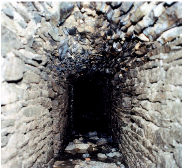
FIGURA 21. Tramo de cloaca abovedada bajo uno de los decumani .
