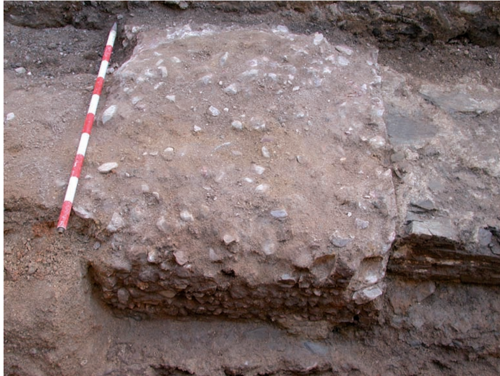
FIGURA 9. Detalle de uno de los pilares del acueducto en su tramo aéreo.
