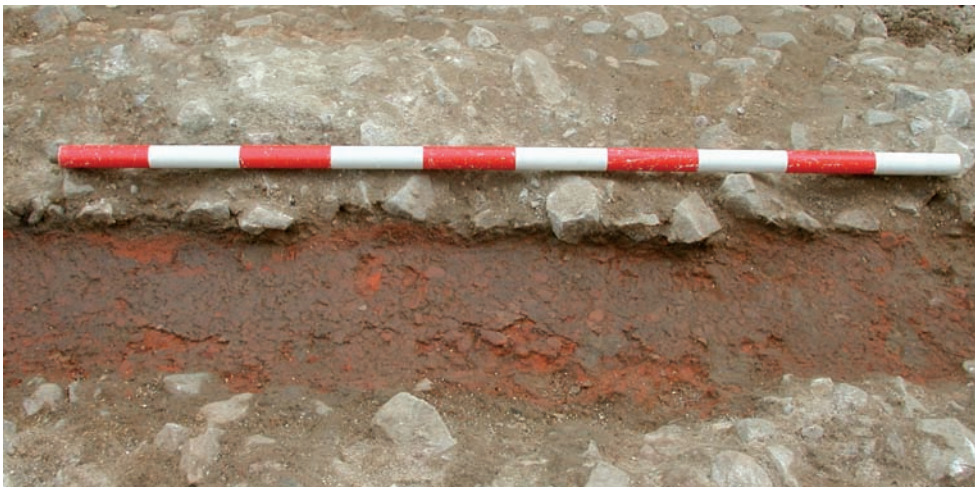
FIGURA 6. Detalle de la capa de ladrillo triturado en el interior del specus .
